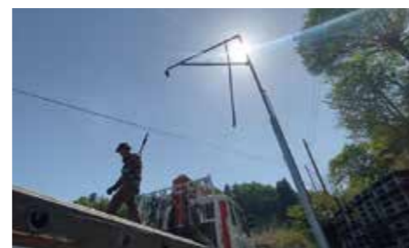
突梁の先端に安全ブロックを取付けて使用
