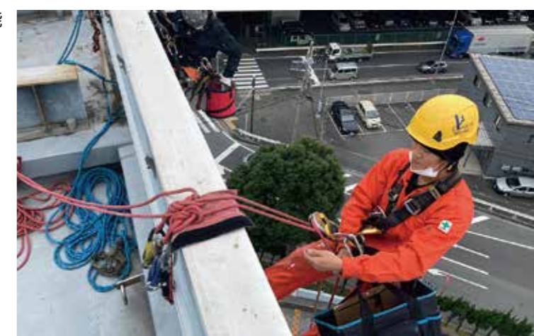
レールタイプを使用したロープアクセス
