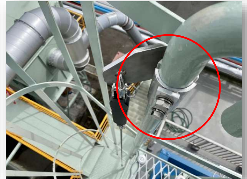
丸型支柱への穴あけ設置例
