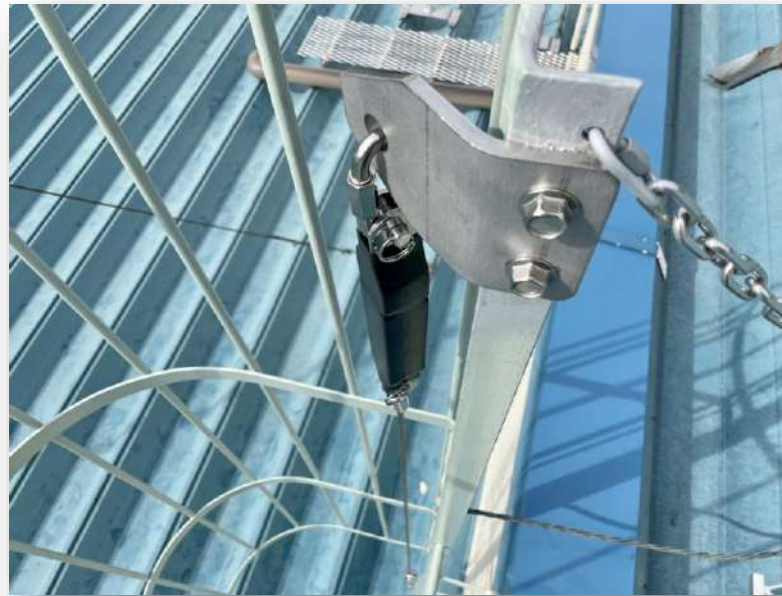
L型支柱への穴あけ設置例
